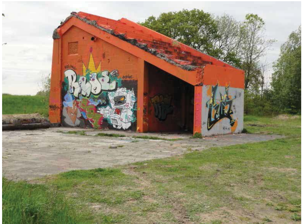
Een deel van de oude schaatstribune staat nog overeind en markeert de oorspronkelijke functie (foto: Anne Garretsen)
